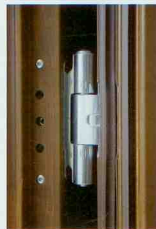
Detail závěsu vchodových dveří – závěs je zařezován v rámu i křídle dveří. To zabraňuje svěšování dveří, tyto závěsy lze snadno seřizovat. SLAVONA
